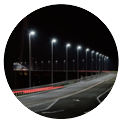
LED道路照明
